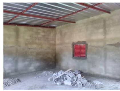
Ramen en deuren plaatsen
