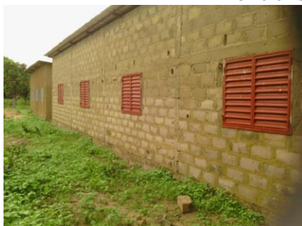
Ramen en deuren geplaatst
