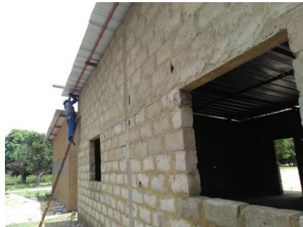
Het dak wordt op de constructie gemonteerd
