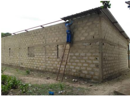
Het dak wordt op de constructie gemonteerd
