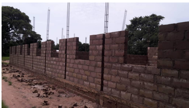
Fase 3 De muren van de klaslokalen worden opgetrokken
