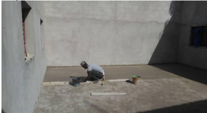
Begin februari werd de vloer afgesmeerd en werd de buitenkant met een laag cement bespoten.
