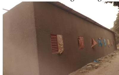
Op 18 februari was de dakconstructie klaar. Het gebouw werd aan de achterkant en de zijkanten met een cementlaag is bespoten. De voorkant wordt later, tegelijk met het binnenschilderwerk, met gekleurde cement bespoten
