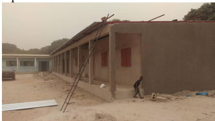
Op 18 februari was de dakconstructie klaar. Het gebouw werd aan de achterkant en de zijkanten met een cementlaag is bespoten. De voorkant wordt later, tegelijk met het binnenschilderwerk, met gekleurde cement bespoten
