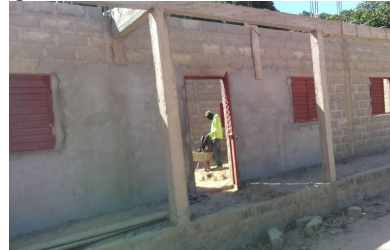
In januari werden de metalen ramen en deuren geplaatst en werd de elektra verder afgewerkt
